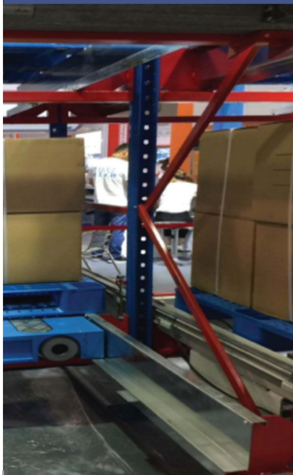
TRANSELEVADOR + SHUTTLE DE CUATRO VÍAS, ALMACÉN AUTOMATIZADO
